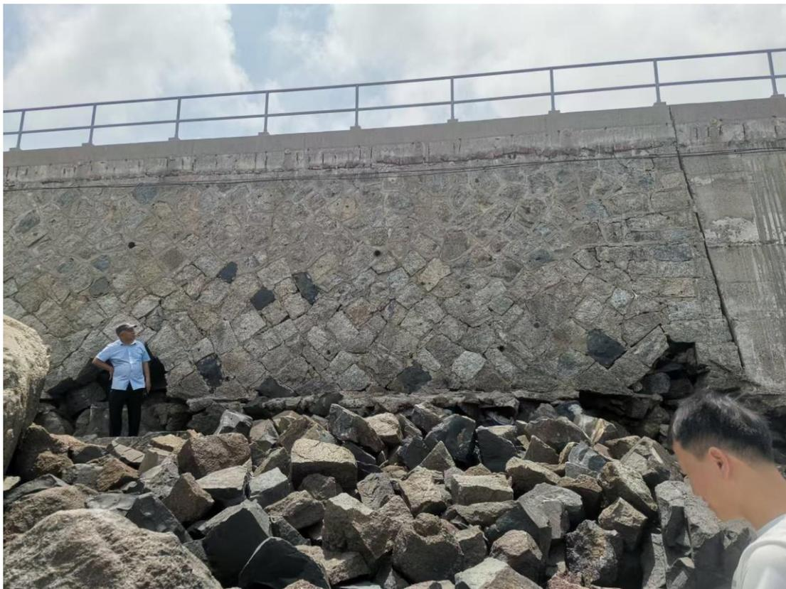
图 2-4 浆砌块石直立式护岸破坏情况
