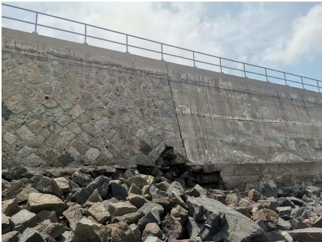
图 2-2 浆砌块石直立式护岸破坏情况
