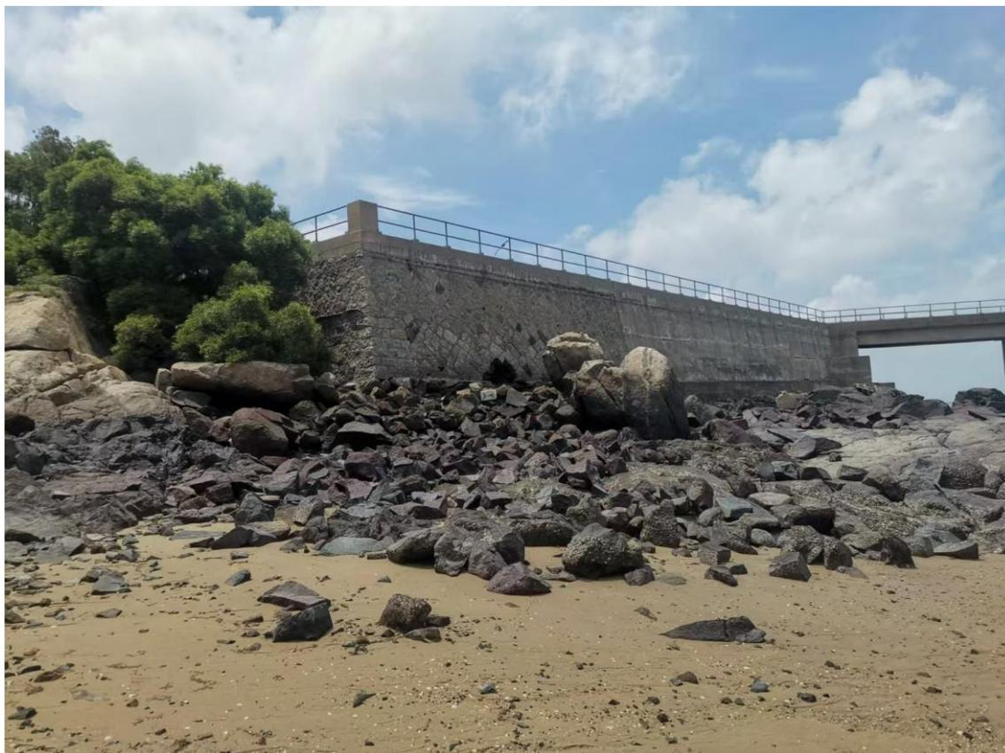
图 2-1 浆砌块石直立式护岸破坏情况
